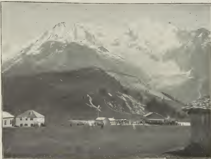
La estación de la garganta de Vonza, término de la sección hasta ahora construida y en explotación
